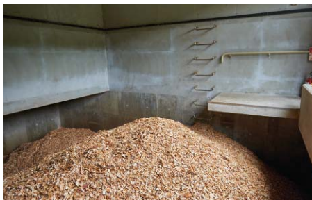
左／ボイラーの燃料に使われる木質チップ 右／地域の暖房・給湯を担うボイラー施設
